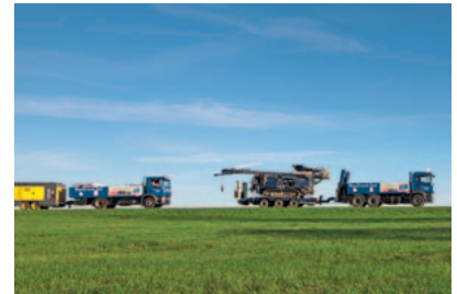
Odwierty pod sondy gruntowe wykonywane przez BauGrund Süd
